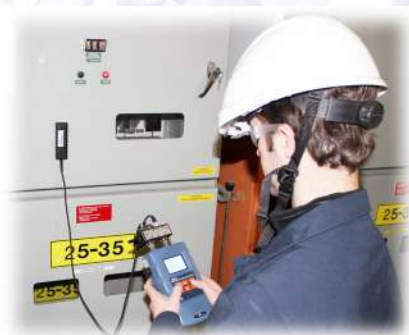
XDP-II con sensor XDP-II-406 en campo
