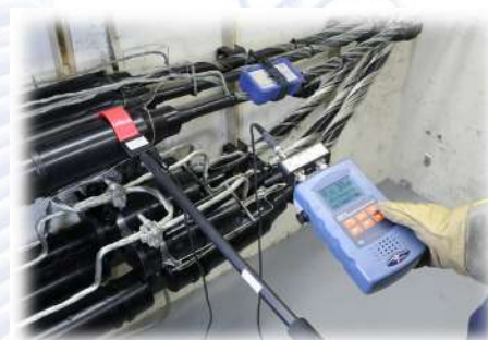
Inspección en campo de empalme en cable
