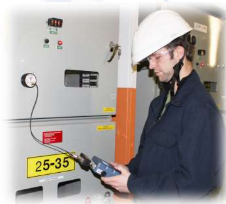
Sensor TEV con XDP-II aplicado en campo
